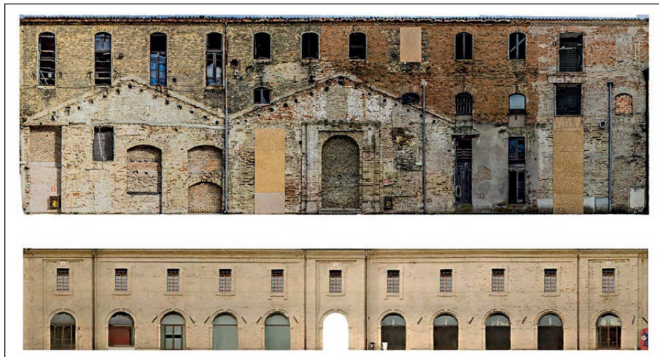
Fig. 2 – In alto: Ortofoto del prospetto SE, lato interno del Lazzaretto. Sulla facciata sono identificabili chiaramente le tracce di una delle fasi storiche: la manifattura tabacchi. I segni presenti sulle murature indicano lo spazio che, dal 1947 al 1997, è stato occupato dai magazzini.
